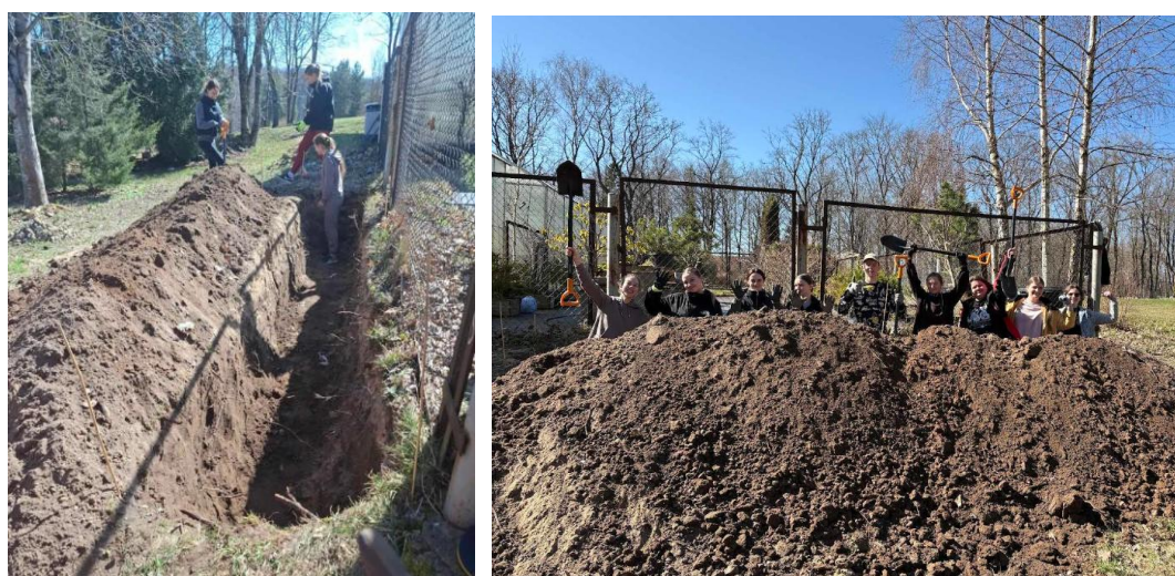
3 pav. Lietaus sodo vietos paruošimo darbai
